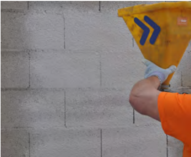
Rys. 2: Nanoszenie natryskowe MasterSeal 560
