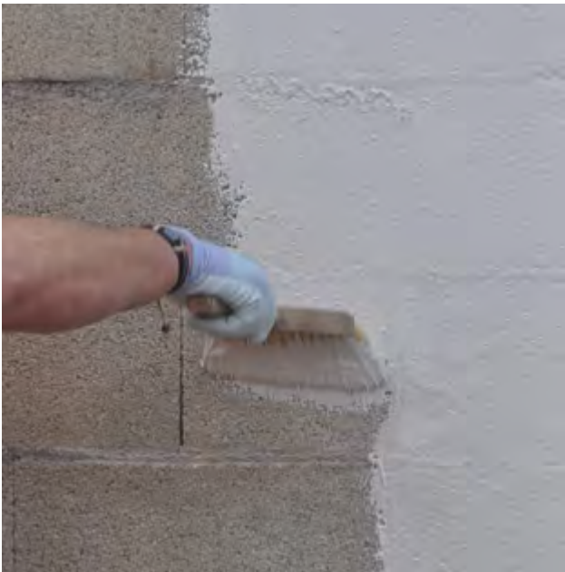
Rys. 1: Nakładanie pędzlem
